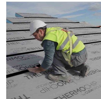
3 Sellado de las juntas, sin arrugas ni burbujas, con cinta adhesiva
