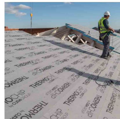
1 Colocación de los paneles en perpendicular a las vigas
