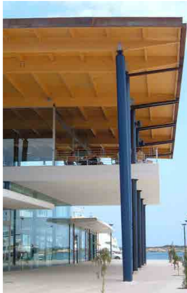
Estación Marítima - Mallorca
